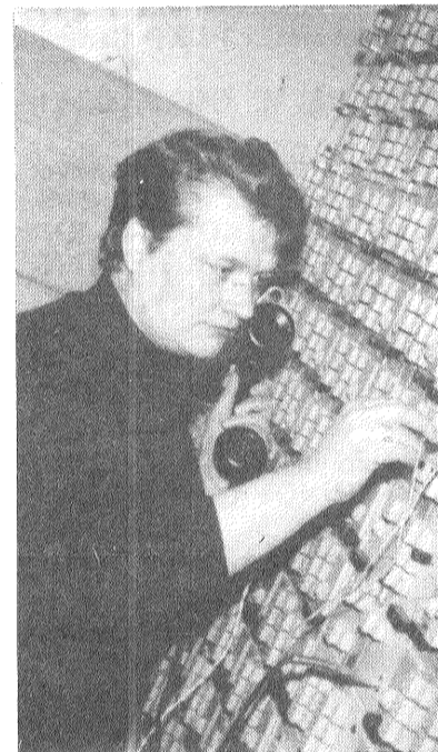
2500 Līvānos apkalpojamo telefona abonētu līniju pieslēgšana un atslēgšana ir Līvānu sakaru tehniskā iecirkņa sestās kategorijas elektromontieres ANTONINAS VILCĀNES rūpju lokā. Viņa gādā par to, lai telefona sakari pilsētā allaž darbotos nevainojami. Un savus pienākumus veic priekšzīmīgi.
