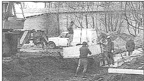
● Top siltumtrase uz Preiļu slimnīcu. J. Silicka foto
