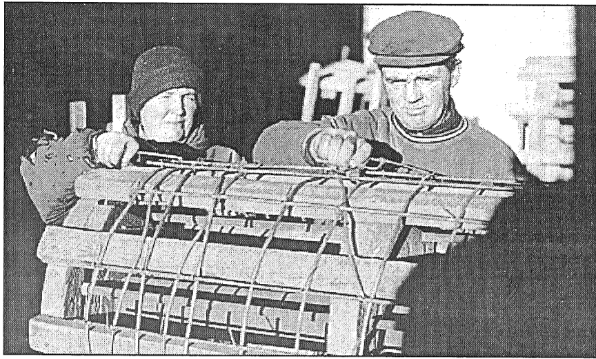
● Dzīvesbiedri Dančauski veido stieplu armatūru kārtējai dzelzsbetona konstrukcijai.
