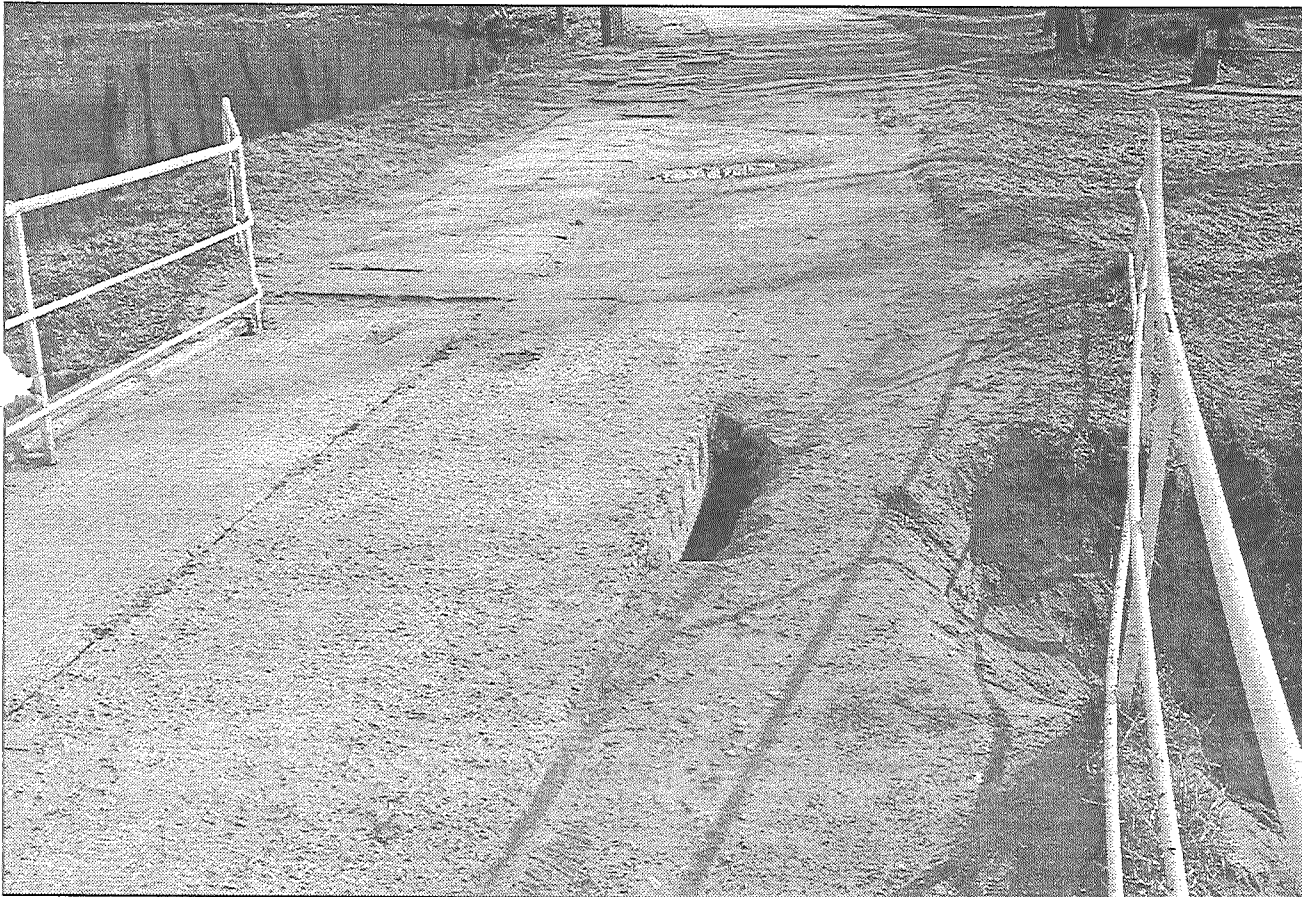
● Caur tiltā izskalojamiem un izdrušušajiem caurumiem var redzēt kanāla ūdeni. Betona plāksnes nav izturējušas laika zobu.
