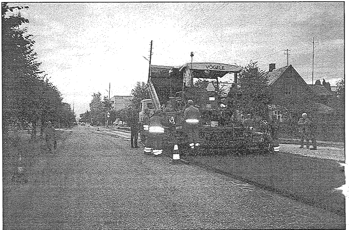
● Jaunuzklātais asfalta segums ir miksts, tā temperatūra 140 grādi. Seguma noturības stiprināšanai virsū tiks klāts granīta šķembu slānis. Foto: G.Kraukle
