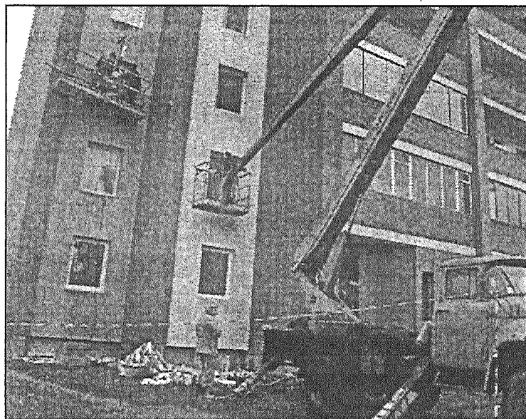
● Tiek siltinātas 35 dzīvokļu mājas āršienas Atmodas ielā.
