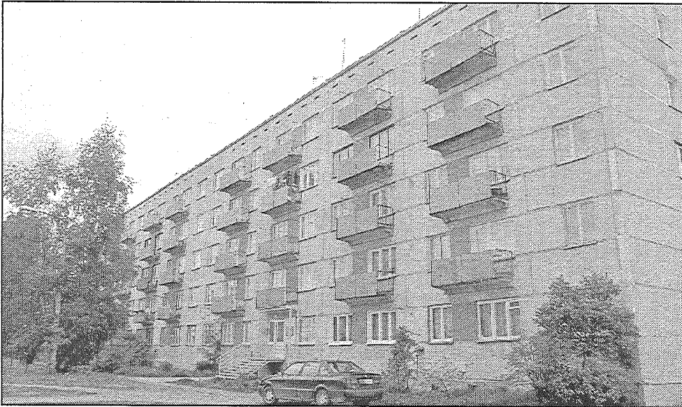
● Veiksmīgi piedaloties valsts Mājokļu aģentūras konkursā, Preiļu dzīvokļu kooperatīvā sabiedrība «Liesma» guva iespēju veikt energoauditu divās no kooperatīvam piederošajām četrām ēkām, arī attēlā redzamajam namam Rēzeknes ielā 34. Tagad jāgādā līdzekļi siltuma zudumu samazināšanai. Foto: A.Stejanovs
