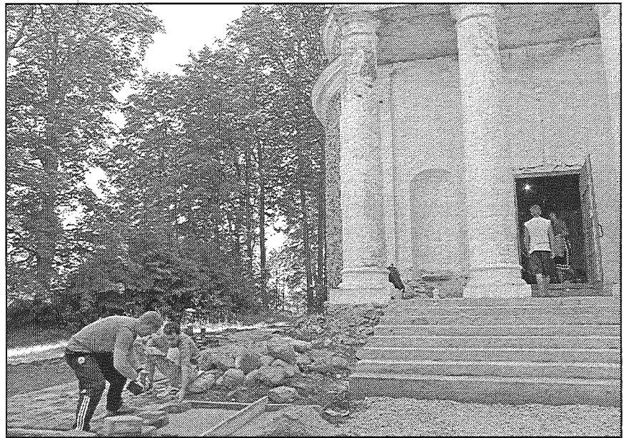
● Preiļu kapelas remontdarbus veic dažādas firmas. Bruģa likšana uzticēta preiļniešiem. Jau septembra sākumā atjaunotā kapela vērs durvis apmeklētājiem. Foto: A.Stepanovs
