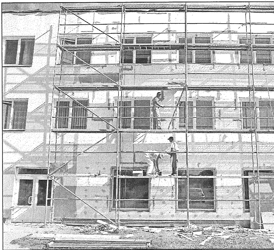
● SIA «Preiļu celtnieks» strādnieki augustā solās pabeigt Liču pagasta centra administratīvās ēkas fasādes siltināšanu un krāsošanu. Kad tiks noņemtas sastatnes, celtnieks būs ieguvusi vizuāli pievilcīgu izskatu. Foto: A.Stepanovs
