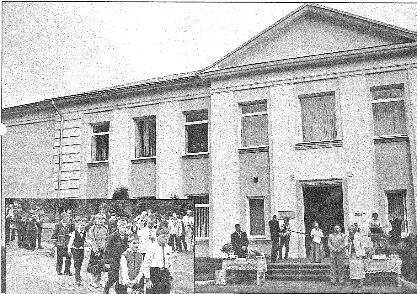
● Rudzātu speciālā internātskola atdzimusi jaunā izskatā. Baltā, pelēcīgā, zaļganā un sūnu zaļā toni krāsotā celtnē 1. septembrī vēra durvis audzēkņu un pedagogu saimei, kuru acu priekšā septiņu gadu laikā skolas saimniecībā risinājušās vērienīgas pārmaiņas. Foto: T.Elste
