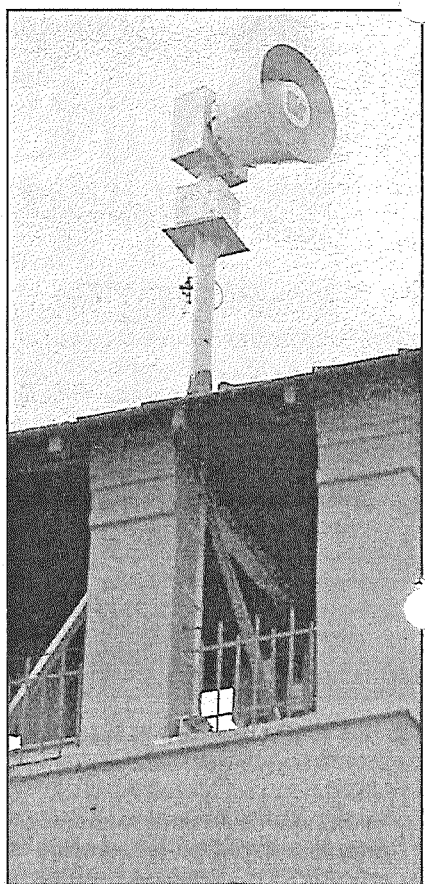
● Latvijā uzstādītas 59 rotējošās elektromehāniskās sirēnas, no kurām 23 atrodas Rīgā, 16 – lielākajās pilsētās un 20 – rajonu centros. Sirēnas uzstādītas uz dzīvojamām mājām un iestāžu ēkām ar aprēķinu, lai radītais skaņas signāls būtu dzirdams apmēram 1,5 kilometru rādiusā (atkarībā no sirēnas izvietojuma augstuma, gaisa mitruma un vēja stipruma).
