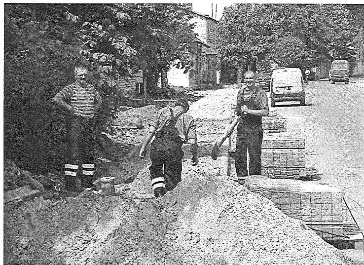
● Pēc pērnā gada nogalē ievilkta gāzes vada tiek atjaunota ietve Brīvības ielā. Kopumā bruģakmeni paredzēts ieklāt posmā no Liepājas līdz Atpūtas ielai.
