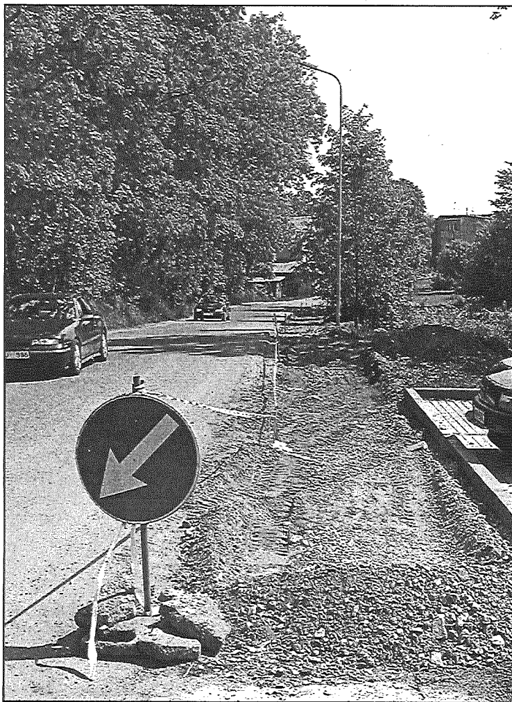
● Mehanizatoru ielā posmā no Daugavpils ielas līdz dzīvojamo namu masīvam notiek ietves pamatnes sagatavošanas darbi. Vasaras nogalē pa jauno bruģa klājumu droši varēs pārvietoties gājēji.
