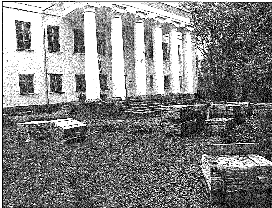
● Pašlaik Vārkavas novada administratīvās ēkas apkārtnē ir pārvērtusies par būvlaukumu. Izraknāti celiņi, bruģakmens kaudzes. Taču pēc vērienīgo remontdarbu pabeigšanas teritorijas izskats būs ievērojami izmainījies. Te atradīsies bruģēti gājēju celiņi, asfaltēts piebraucamais ceļš, stāvlaukums, ierīkots apgaismojums.
