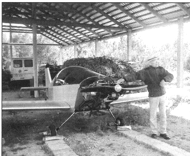
● Liels bērns spēlējas ar konstruktoru — tā par Kārļa Bēta aizraušanos, būvējot lidmašīnu, saka daļa vietējo. Bet viņam tas ir hobijs un jaunības sapnis. Rasējumi, konsultācijas, speciālo videomateriālu skatīšanās par lidmašīnas būvi ir nieks, salīdzinot ar 16 000 pašrocīgi nostiprināto kniedīšu, kas satur kopā lidaparātu.
