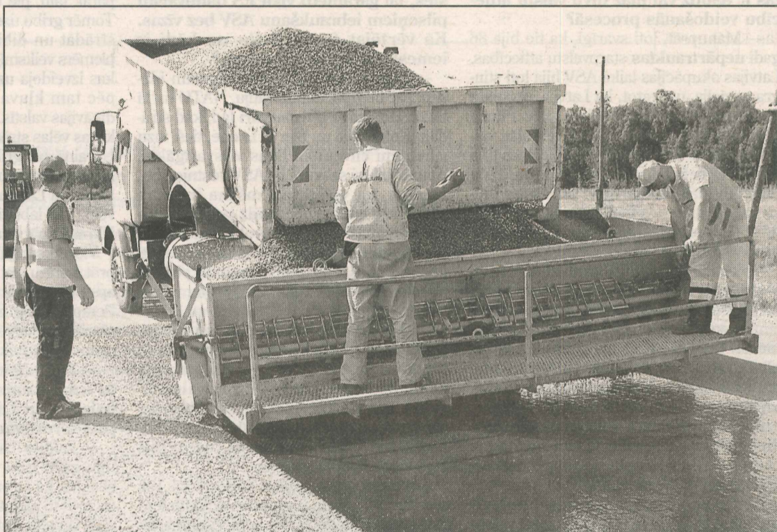
● Kūpošajai un uz asfalta svaigi uzlietai bituma emulsijai, kas atvesta no Igaunijas, ceļinieki ber granīta šķembas, ko sarūpējuši zviedri. Dārgi gan, bet vismaz gadus piecus sešus par jauna asfalta klāšanu domāt nevajadzēs. Foto: A.Šņepsts
