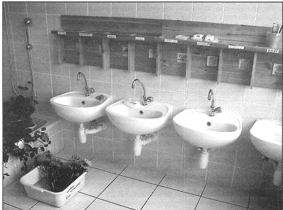
● Sanitārie mezgli pēc remonta.
