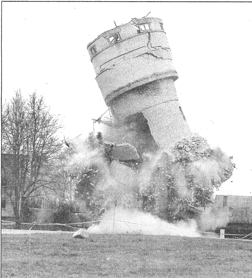
● Otrdien, 9. decembrī, Preiļos, izmantojot spridzināšanas metodi, tika demontēts pagājušā gadsimta piecdesmitajos gados būvētais un jau vairākus gadu desmitus neizmantotais ūdenstornis Aglonas ielas galā. Dažu sekunžu laikā tas pārvērtās gruvešu kaudzē. Foto: E. Binders
