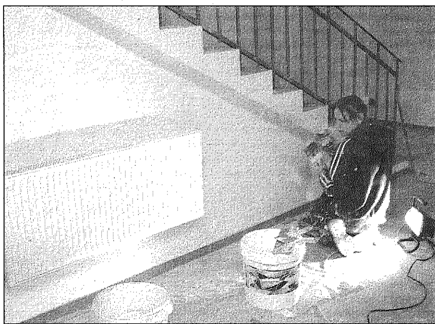
● Celtnieki strādā rūpīgi, tāpēc aglonieši var cerēt, ka saietu nams pēc rekonstrukcijas izskatīsies kā no jauna piedzimis. Šis attēls tapa vēl oktobrī, bet pašlaik darbi jau krietni pavirzījušies uz priekšu. Foto: A.Šņepsts
