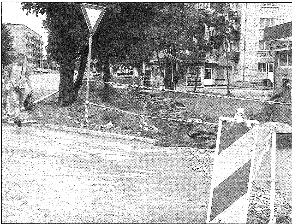
● Ietvju rekonstrukcija Rīgas ielā posmā no Rūpniecības līdz Zaļajai ielai paredz arī divu jaunu gājēju pāreju izveidi, viena no tām pēc iedzīvotāju lūguma būs iepretim veikalam Maxima.
