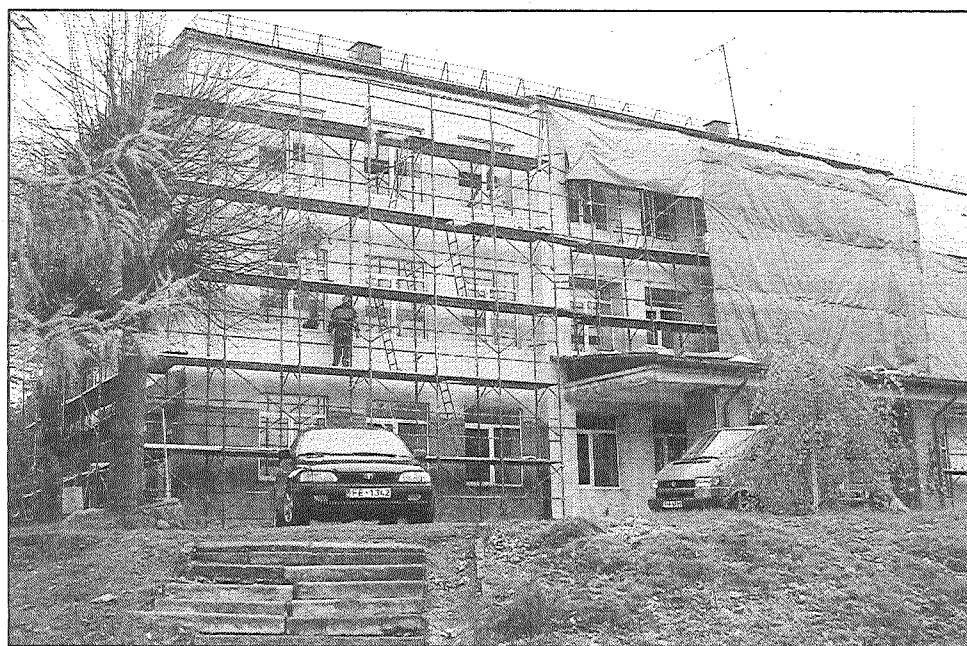
● Aglonas vidusskolā īstenotais energoefektivitātes projekts dažādu apstākļu dēļ ieidzīs. Sākotnējie būvdarbu beigu termiņi celtniekiem pagarināti par pusotru mēnesi.
