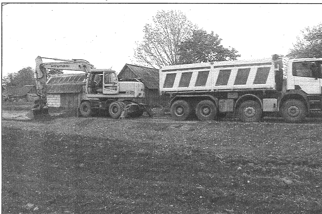
● SIA “Ošukalns” šovasar veic remontdarbus uz septiņiem Preiļu novada ceļiem.
