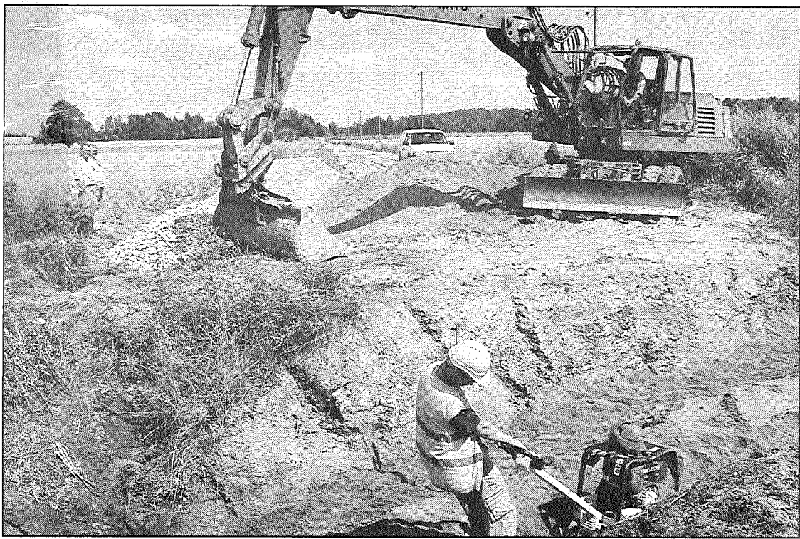
● SIA «SAU» tehnika un strādnieki pagājušajā nedēļā bija nodarbināti ar caurtekas izbūvi uz ceļa. Melnzemes virskārta slēpj glūdas jeb zilā māla slāni.
