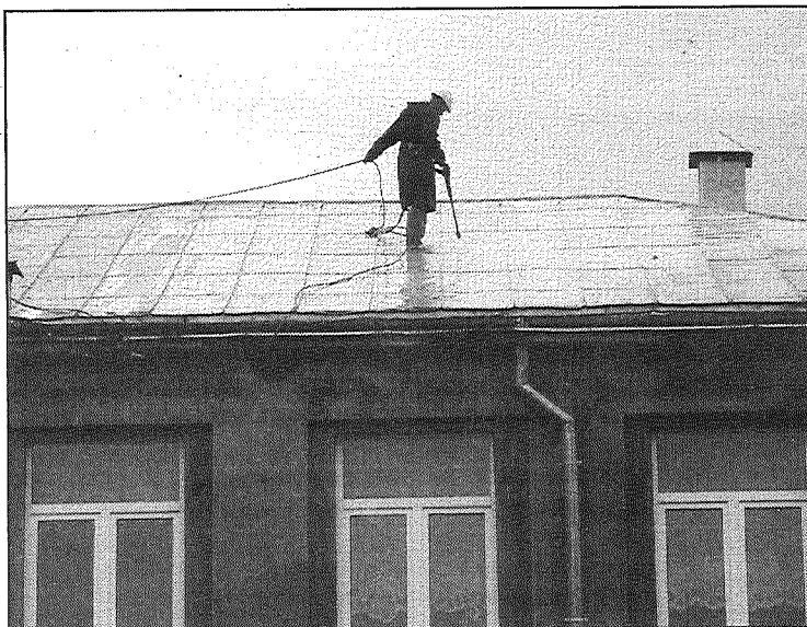
● Uz Preiļu mūzikas un mākslas skolas ēkas jumta speciālisti ar augstspiediena mazgājamām iekārtām novāc nosēdumus un netirumus. Pēc tam klājums tiks apstrādāts pēc jaunas tehnoloģijas, kas nodrošinās ūdens necaurlaidību. Foto: L.Kirillova
