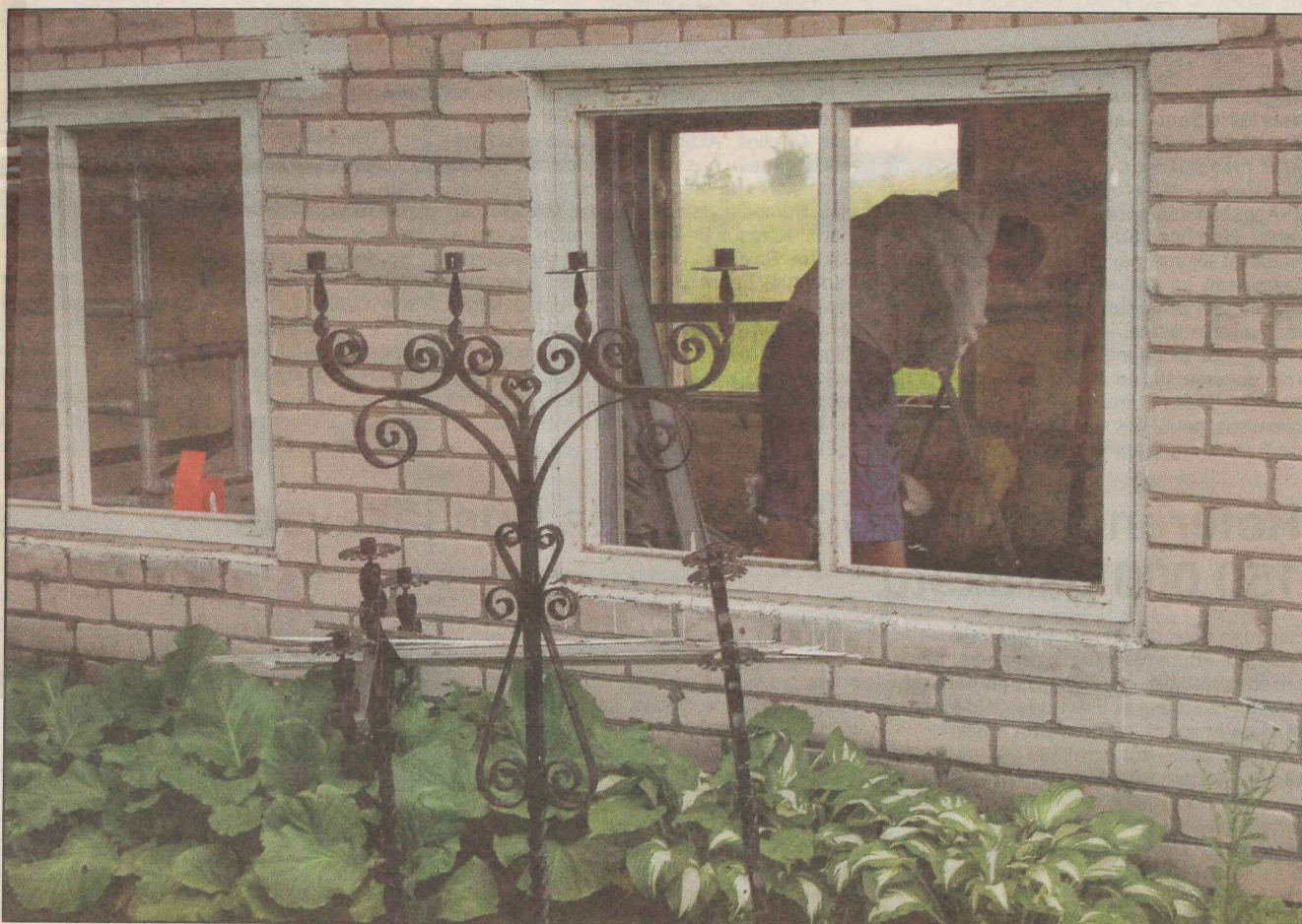
● Sutru kapsētas kapliča rit remontdarbi, kam finansējumu piešķirusi Līvānu novada dome. Foto: A.Šņepsts
