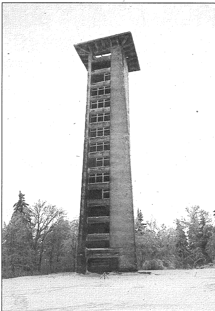
● Gaiziņkalns iepriekšējā izskatā ar vēl nenojaukto torni.
