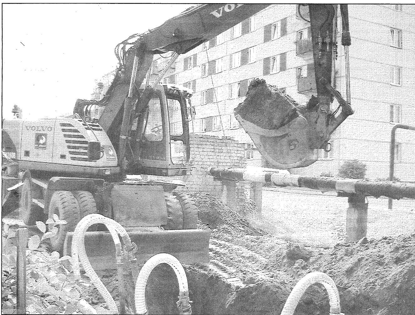
● Rit kanalizācijas tīklu izbūves darbi A.Upīša ielas mikrorajonā.
