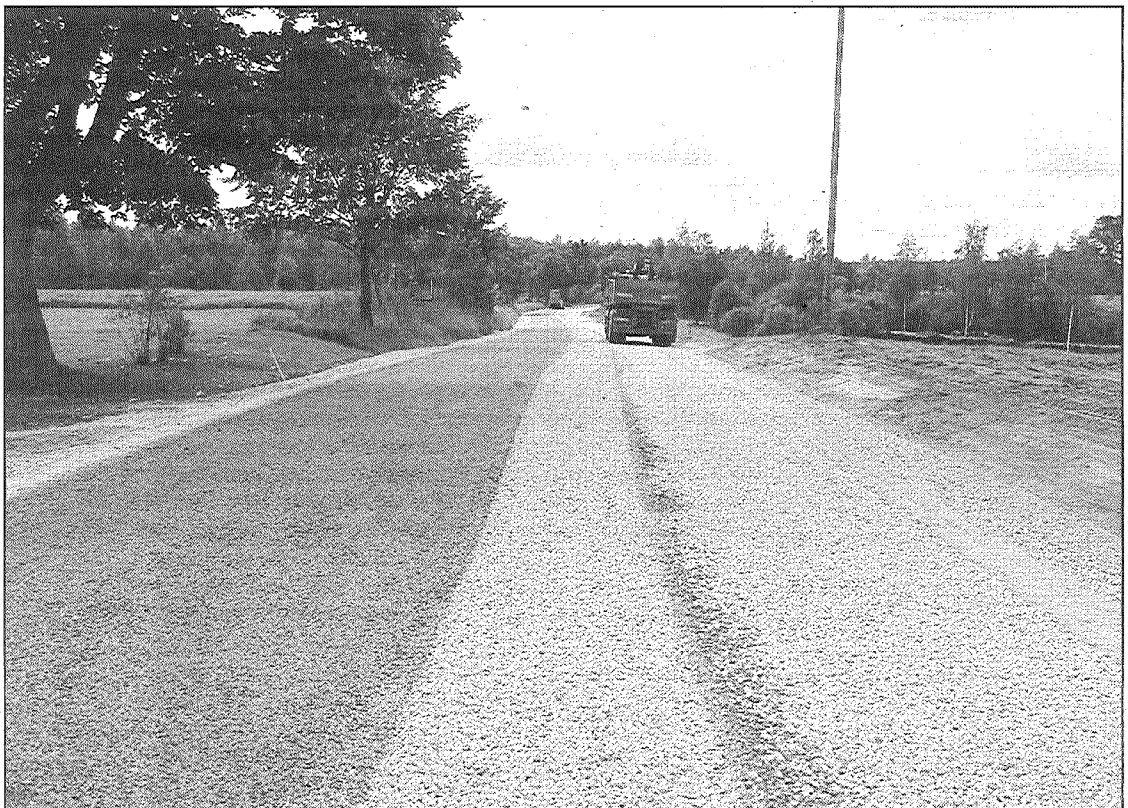
● Attēlā redzams, kā notika grants ceļa dubultā apstrāde ar melnajām šķembām uz ceļa Livāni — Gavartiena — Steķi. Labajā pusē — noklāta šķembu pirmā kārtā, kreisajā — noklāta šķembu otrā kārtā. Foto no a/s «Latvijas valsts ceļi» Latgales reģiona Preiļu nodaļas arhīva.
