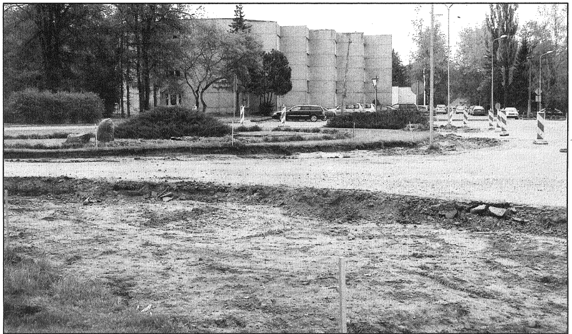
● Jau vasaras vidū pavisam savādāk izskatīsies galvenais krustojums, jo tiks mainīta satiksmes organizācija. Foto: I.Kirillova
