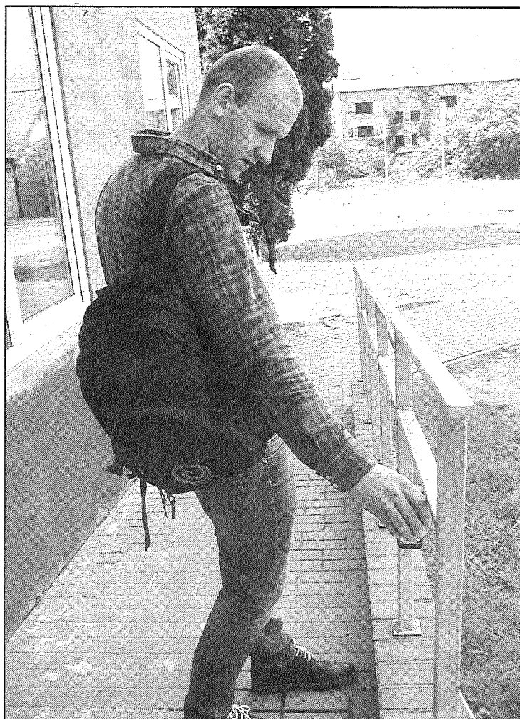
● Uzbrauktuves roku balsti atrodas 90 un 70 centimetru augstumā, kas ir pārāk augstu cilvēkam ratiņkrēslā. Foto: L.Kirillova
