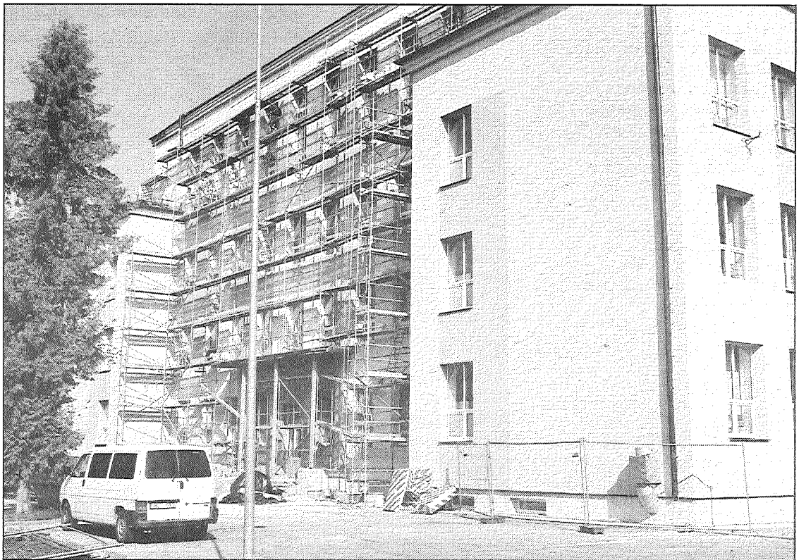
● Preiļu 2. vidusskolu ieskauj sastatnes. Turpinās ēkas siltināšanas darbi.
