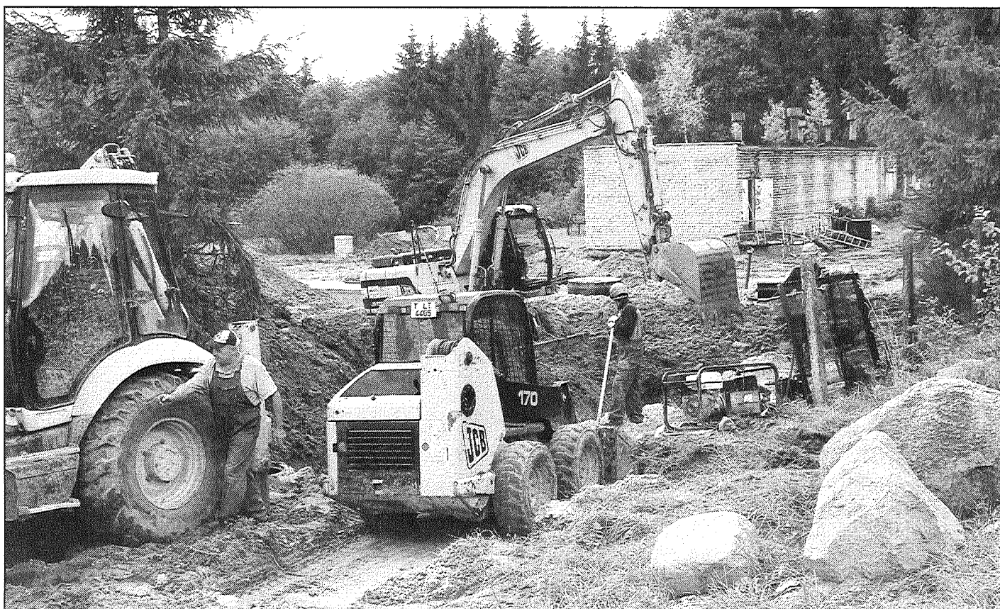
● Jaunaglonā paralēli vecajam top jauns maģistrālais vads kanalizācijas ūdeņiem, kas jau nākamā gada sākumā tiks attīrīti jaunajās attīrīšanas iekārtās. Darbus veic pilnsabiedrības «UNL-K» speciālisti no Krāslavas. Foto: A.Šņepsts
