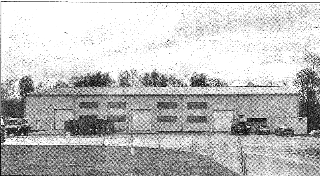
● Mūsdienīgās iekārtas ir uzstādītas angārā.
