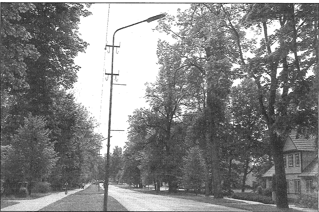
● Kad apgaismojuma nomaiņas projekts tiks īstenots, Raiņa bulvārī novecojušās laternas nomainīs moderni LED gaismekļi. Foto: I.Kirillova
