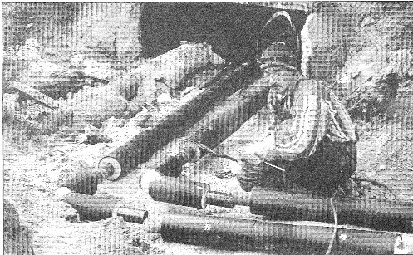
● Siltumtrašu rekonstrukciju veic SIA «Cēsu specceltnieks». Attēlā elektrometinātājs Aleksandrs Bajukovs.
