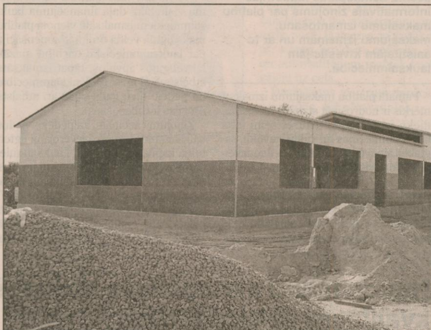
● Oktobra beigās Rēzeknes ielas galā pie Preiļu apvedceļa durvis vērs uzņēmuma «M.T.Z. Serviss» lauksaimniecības tehnikas tirdzniecības centrs, kas pagaidām būs vienīgais Latgalē. Celniecības darbus veic būvfirma «ZDZ» no Gulbenes. Foto: A.Šņepsts
