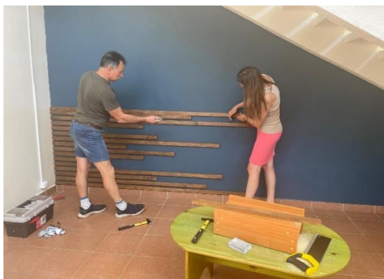
3.2.3. att. Sienas dekorēšana ar dēļiem
