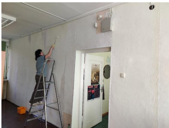
3.1.att. “Sienu kosmētiskais remonts Aizkalnes bibliotēkā”
